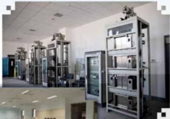
智能电梯安装调试 维护训练场所
